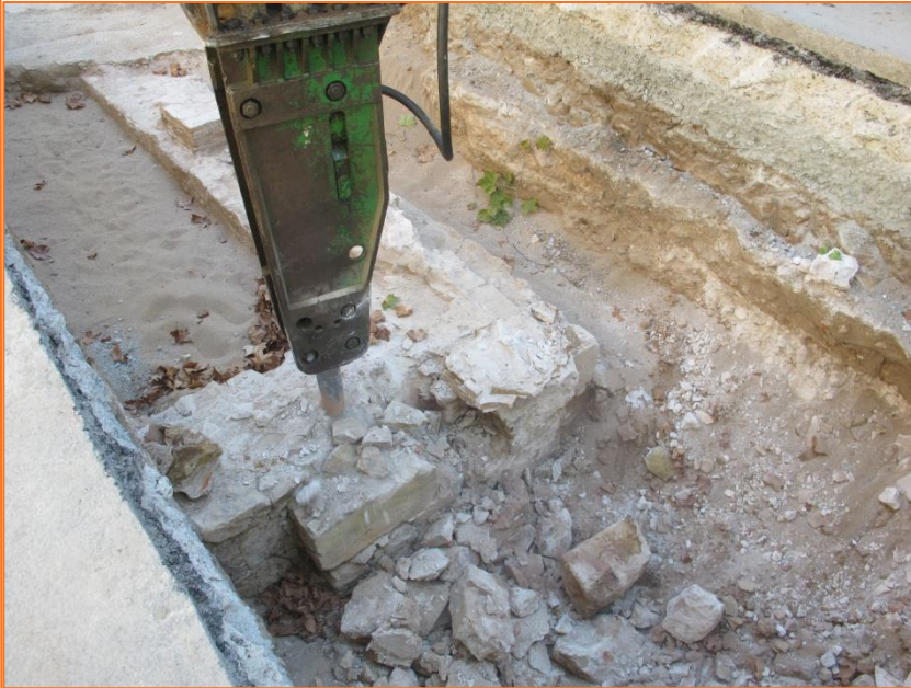
Foto 37. Vista del desmuntatge dels murs UE 8, 16, 17 i 30.
