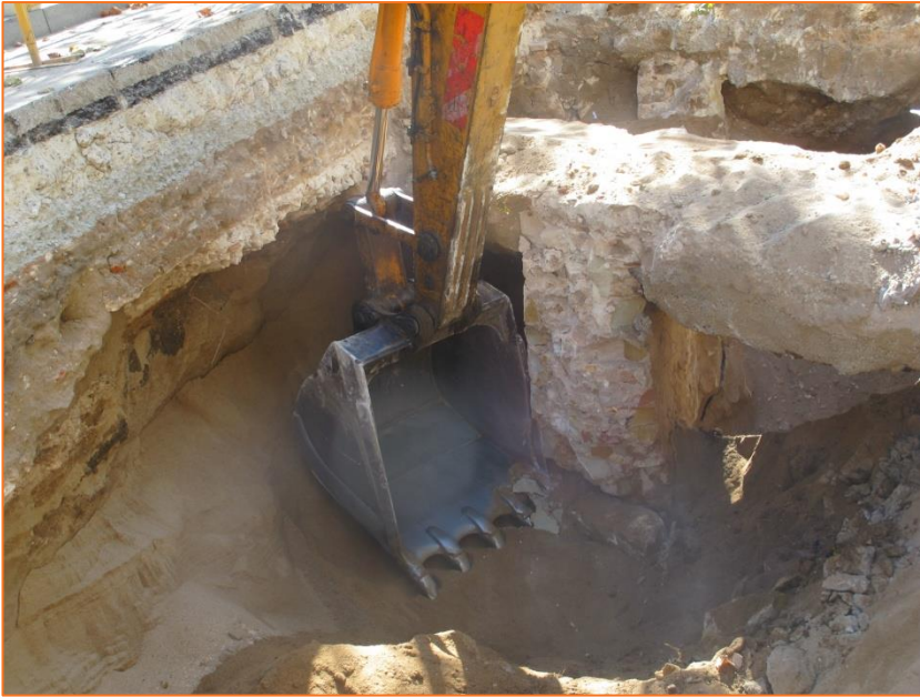
Foto 41. Vista del desmuntatge de l'estructura de fonamentació mur UE 8.
