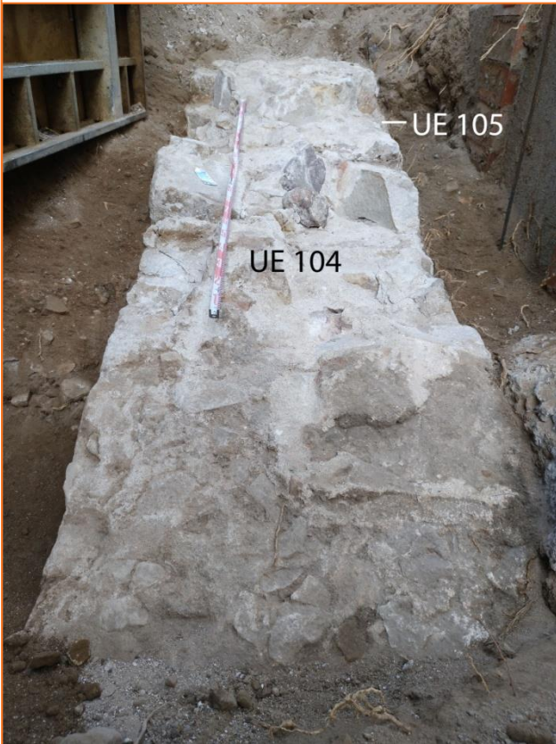
Foto 89. Vista del mur UE 104 (MR 3) i el seu revestiment (UE 105).
