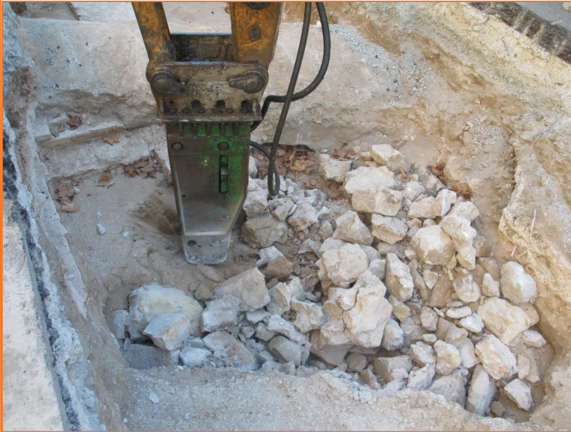
Foto 39. Vista del desmuntatge dels murs UE 8 i 15.
