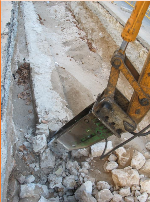
Foto 40. Vista del desmuntatge dels murs UE 8, 42 i 44 i l'envà UE 41.
