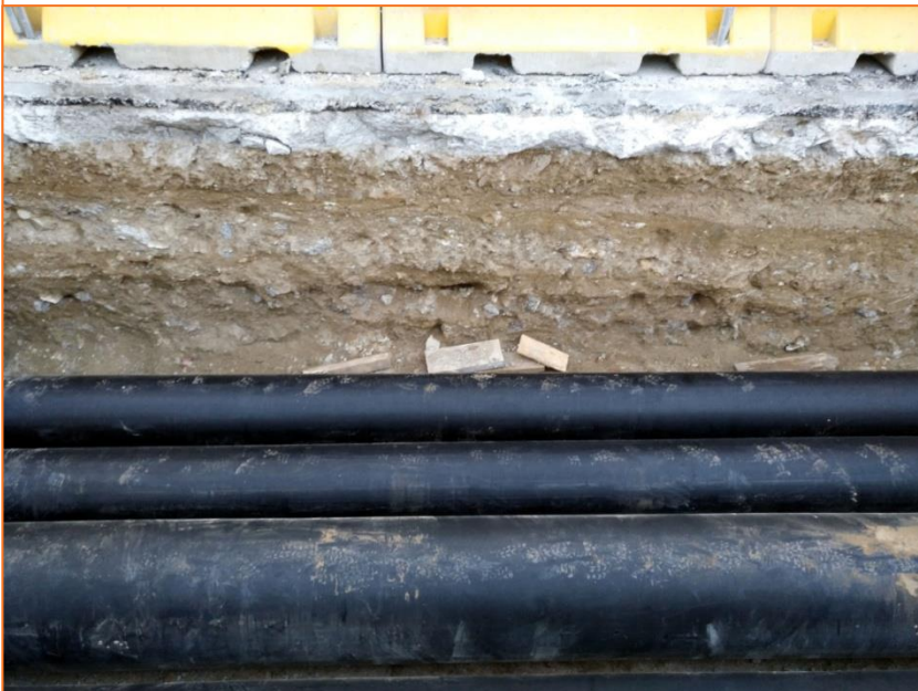
Foto 62. Vista frontal d'un dels perfils de la rasa al carrer de Salvador Espriu.
