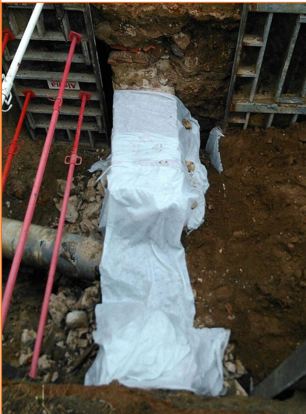
Foto 148. Vista del mur MR 7 tapat amb geotèxtil i protegit amb el rebliment.
