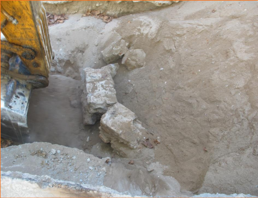
Foto 35. Vista del desmuntatge dels murs UE 32 i 37.
