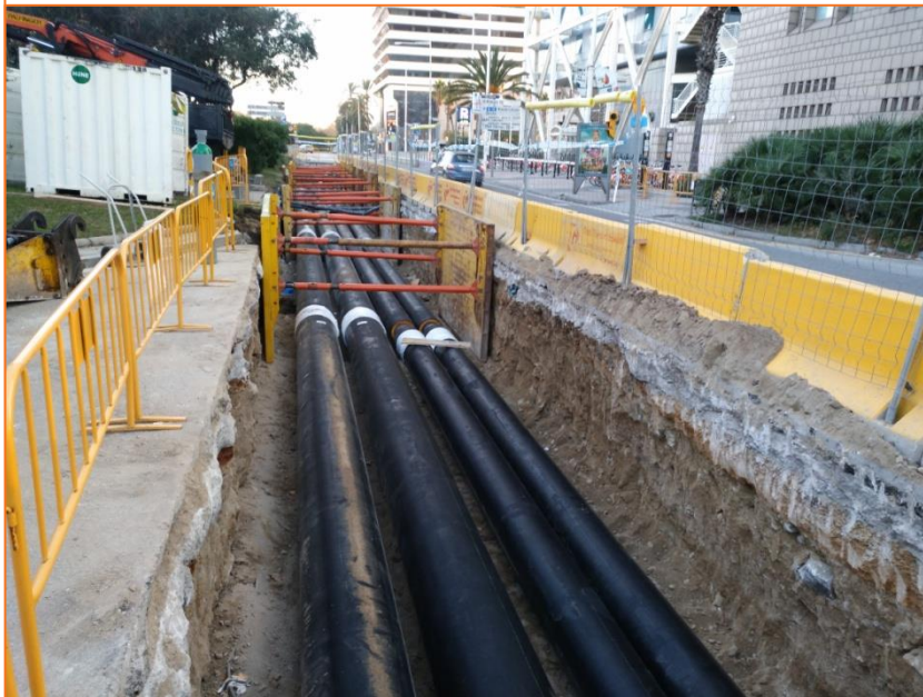
Foto 64. Vista de la rasa de l'Avinguda del Litoral.
