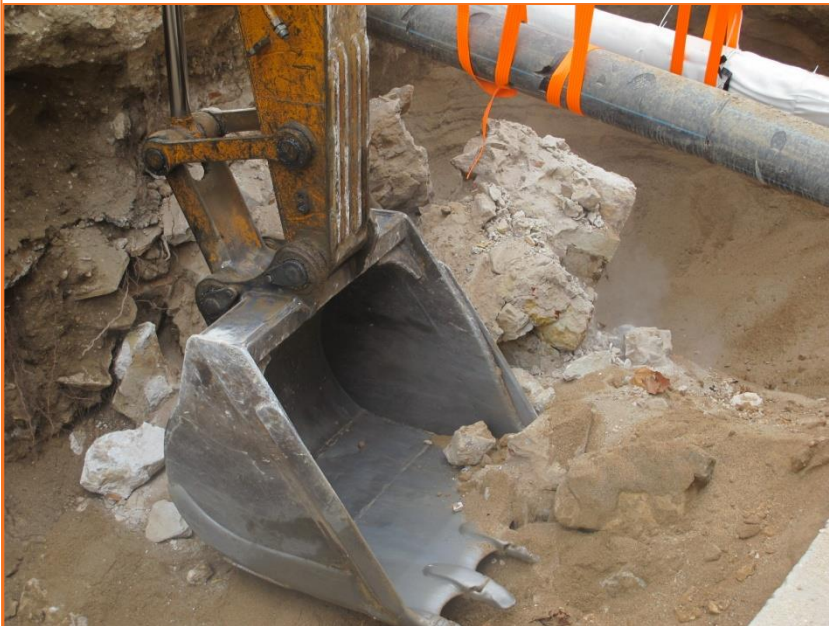
Foto 42. Vista del desmuntatge del tancament SE de l'edifici (UE 8).
