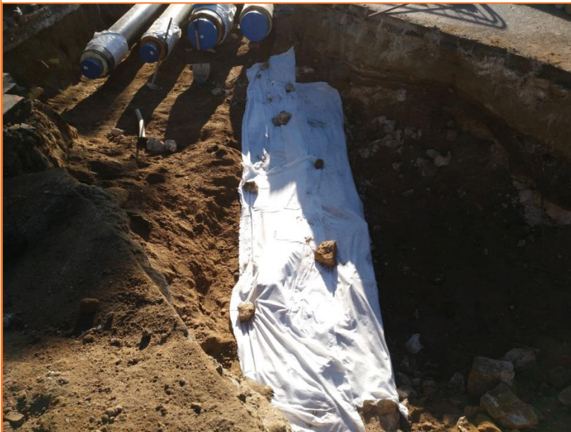
Foto 144. Vista del mur UE 148 (MR 6) tapat amb geotèxtil abans del rebliment.
