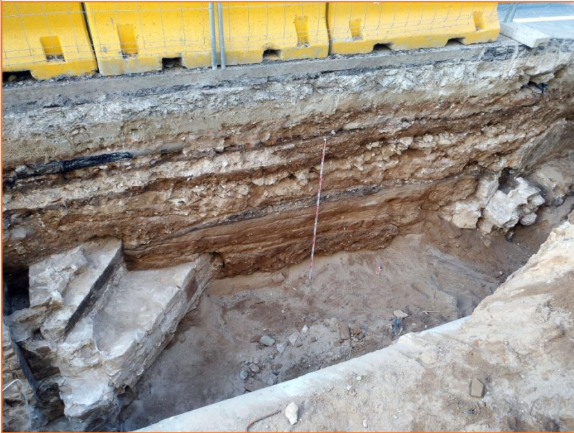
Foto 103. Vista del camí a cobert de la Ciutadella en el punt d'unió amb el fort de Don Carlos. S'observen les pollegueres de les portes sud i nord que donen accés a les corresponents ales del fort.
