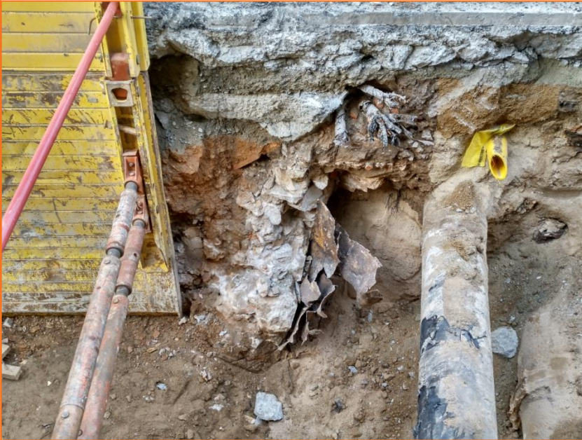
Foto 69. Vista del mur atalussat UE 73 d'un soterrani o dipòsit.
