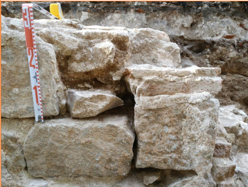
Foto 96. Vista de detall del negatiu de forat de pal o bastida (UE 112) obert al mur UE 104 (MR 3) i el seu farciment UE 114.
