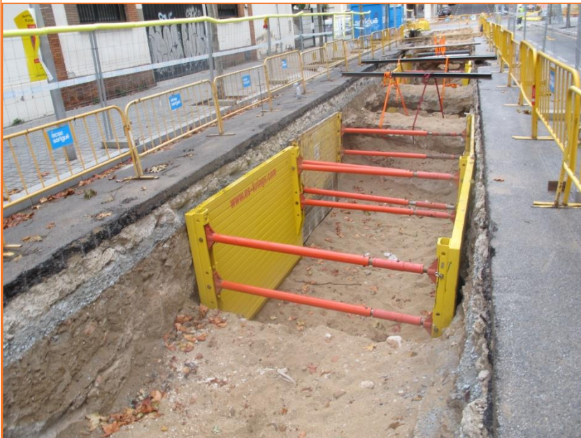
Foto 44. Vista de la rasa del carrer d'Àvila després del desmuntatge de les estructures UE 8, 15, 16, 17, 30, 36 i 37.
