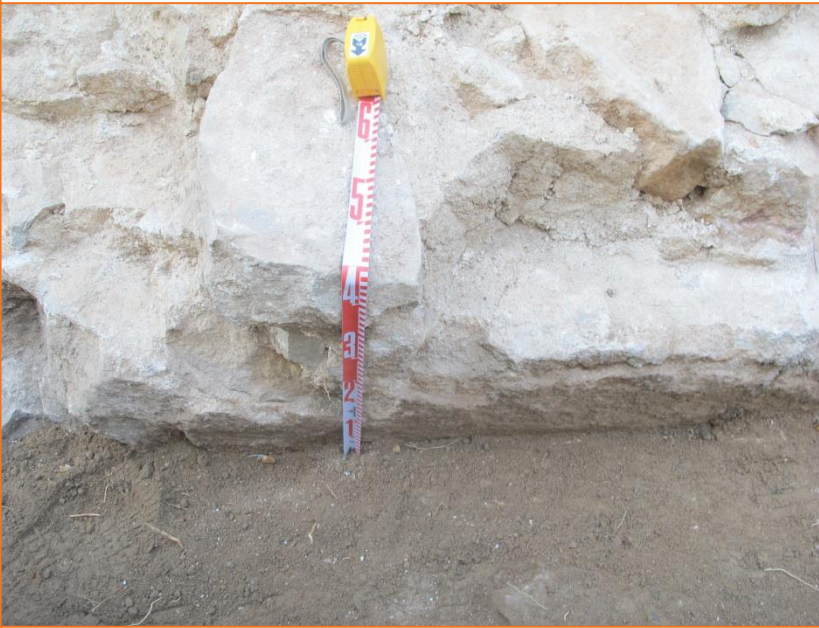
Foto 91. Vista de detall del revestiment UE 105 de MR 3.
