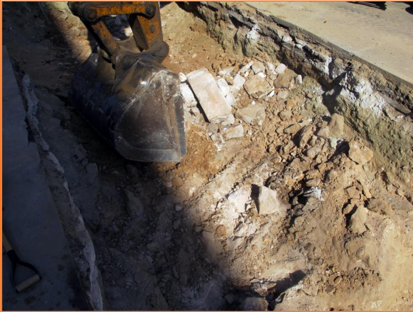
Foto 47. Vista del desmuntatge de la claveguera UE 59 i excavació de UE 23.
