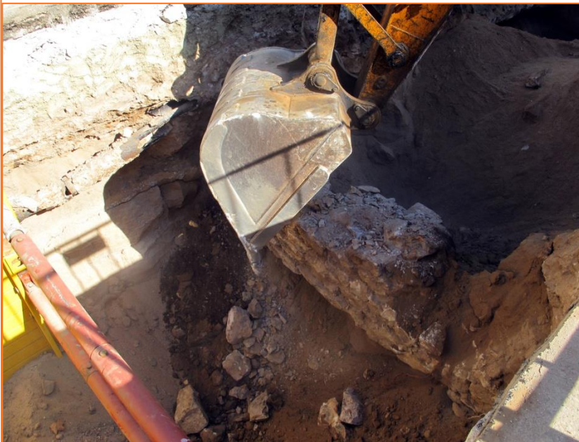
Foto 50. Vista del desmuntatge del mur aeri 61 i la fonamentació UE 62.
