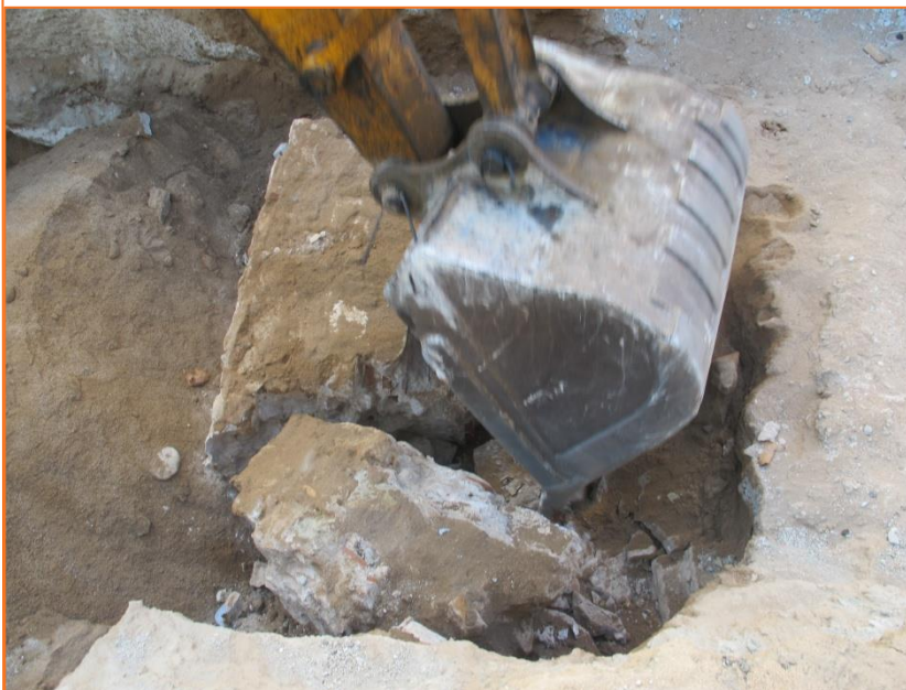
Foto 34. Vista del desmuntatge dels murs UE 50 i 54.
