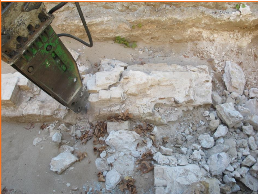
Foto 38. Vista del desmuntatge dels murs UE 8 i 17.
