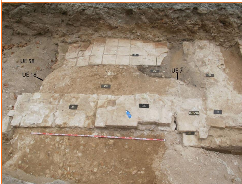
Foto 10. Vista de l'àmbit 1, delimitat pels murs UE 16 i 36, sobre els seus fonaments UE 30 i 37 respectivament, amb el paviment UE 21.
