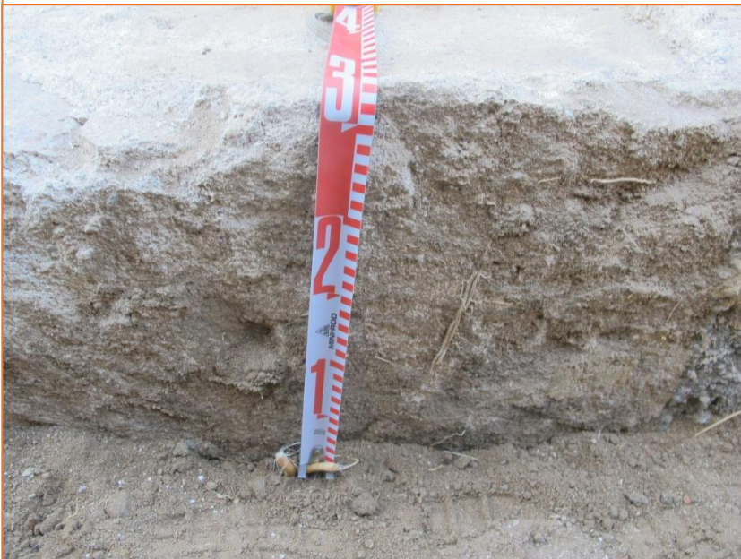
Foto 90. Vista de detall del revestiment UE 105 de MR 3.
