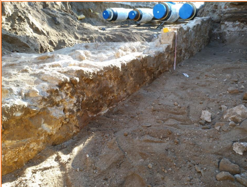
Foto 120. Vista de la cara exterior del mur UE 148 (MR 6), el nivell que se li entrega correspon al terraplenat de les obres de 1888 (UE 89).
