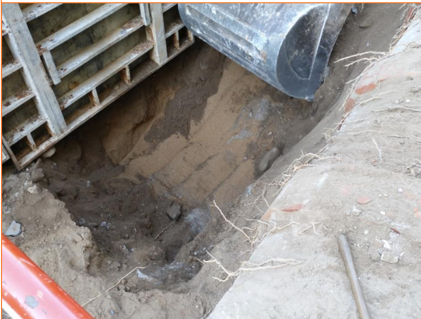
Foto 86. Nivell de sorres d'anivellament UE 169 que s'adossen al mur UE 102 i sobre les que s'assenta el revestiment exterior UE 101. Són cobertes per UE 89.
