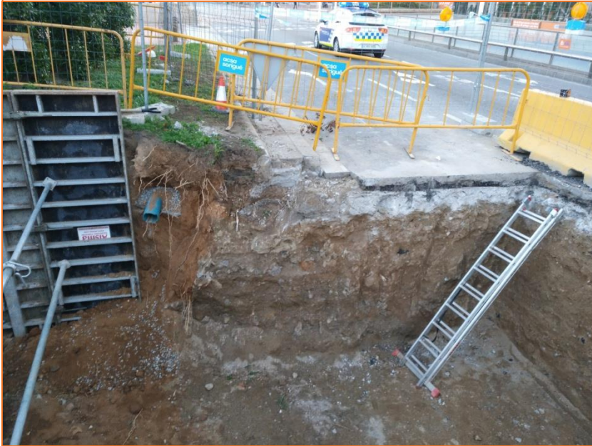
Foto 63. Vista de la rasa de l'Avinguda litoral en el punt d'unió amb el parc de les Cascades.
